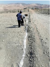
Trazado de lineas para tubos
