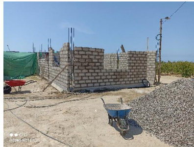
Construcción área de secado
