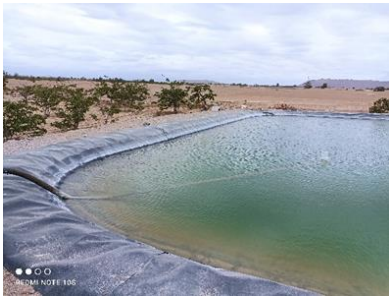
Reservorio de geomembrana
