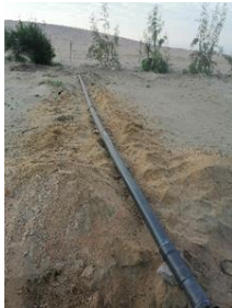
Instalando Tuberia para riego
